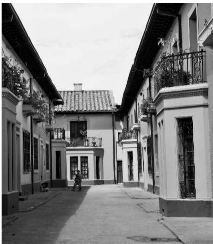
Pasaje Gómez, calle 16 con 17. Fotografía
